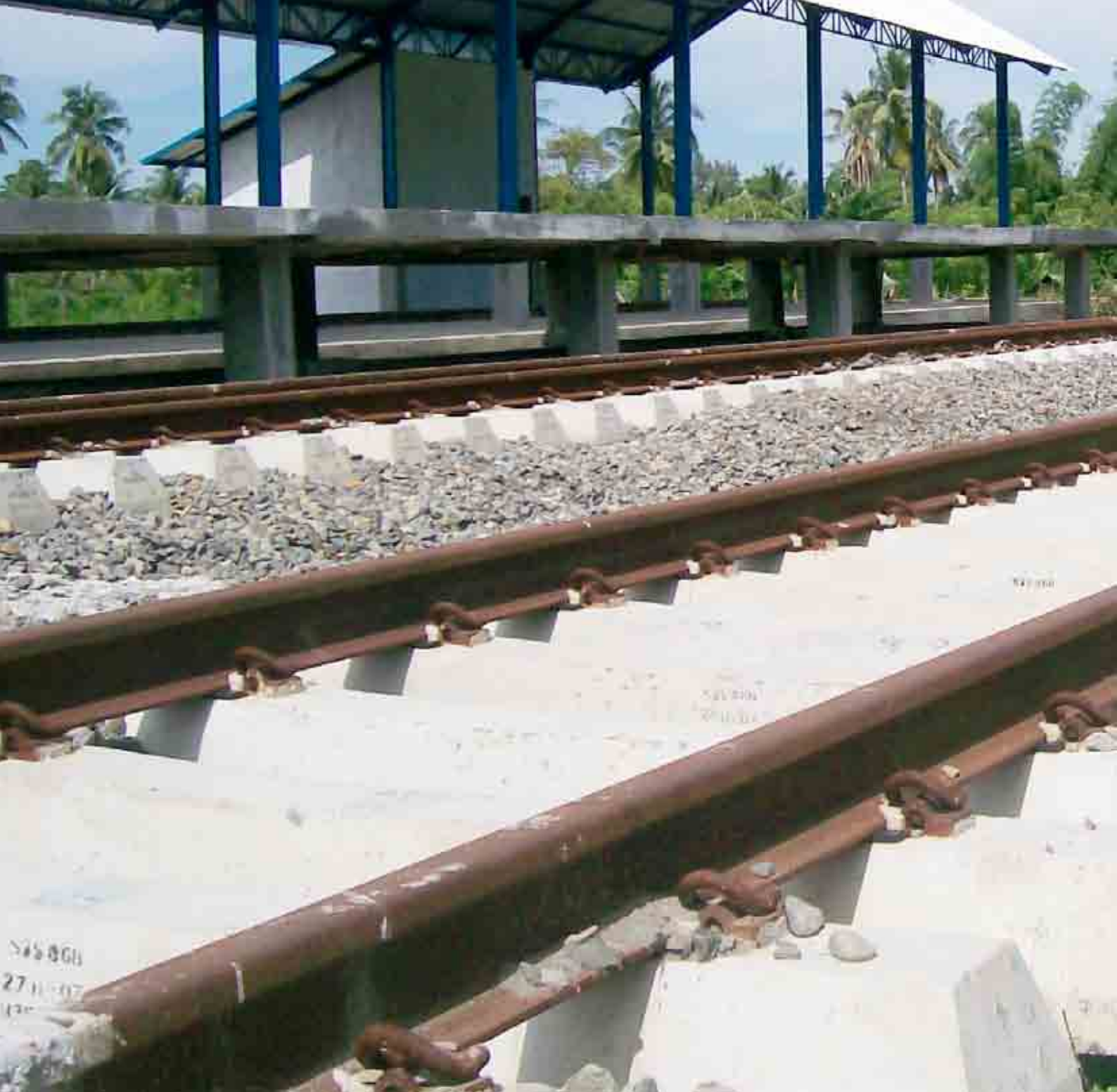
Proyek Jalan Kereta Api - Aceh Rail Road Project - Aceh
