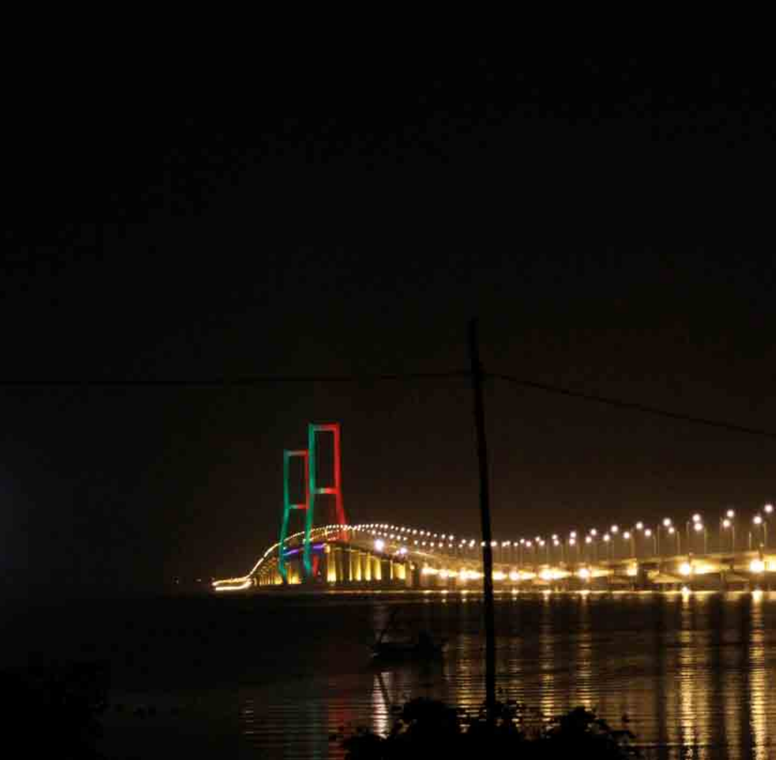
Proyek Jembatan Suramadu - Jawa Timur / Suramadu Bridge Project - East Java
