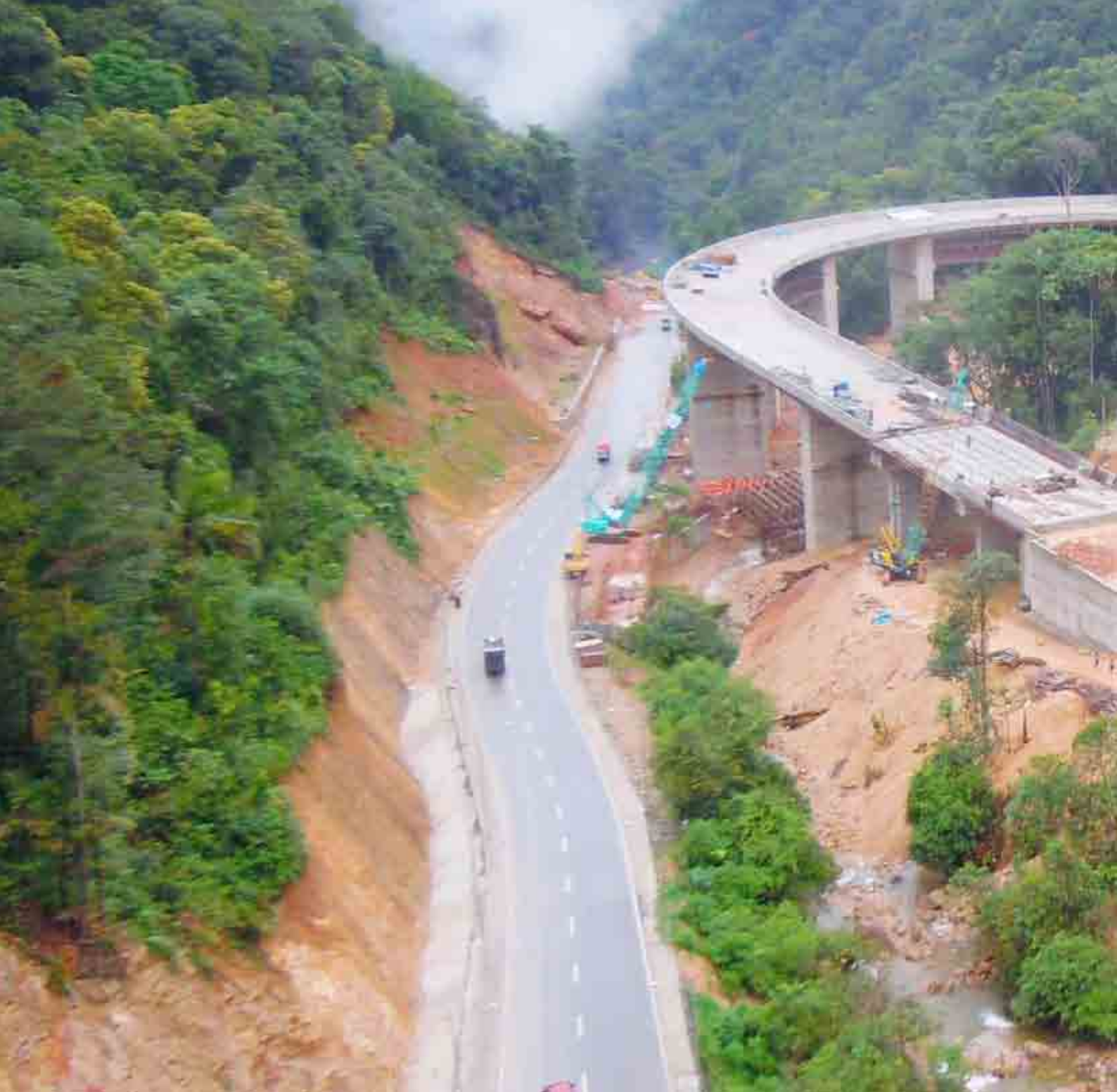
Proyek Jembatan Kelok 9 - Sumatera Barat Kelok 9 Bridge Project - West Sumatera
