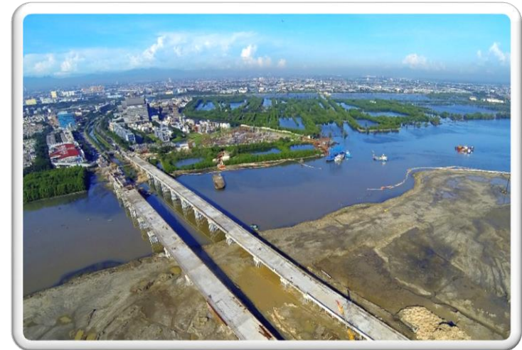
Proyek Reklamasi Agung Sedayu Group
