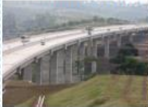
Jembatan Cikubang – Cipularang (2006)
