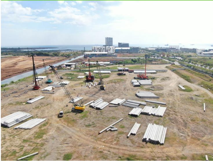
Pembangunan Ciputra World Mall (CWM) Makassar
