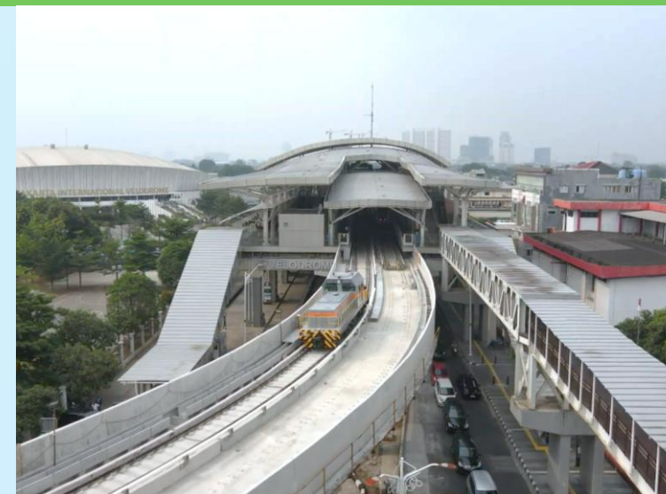
LRT Jakarta Fase 1B Velodrome - Manggarai
